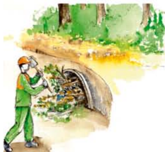
Fig 29. La limpieza de cunetas y otras zonas de desagües se hará al final de los trabajos.
