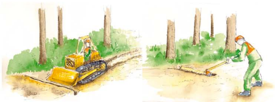
Figura 21. Ejecución de cortes de agua.
